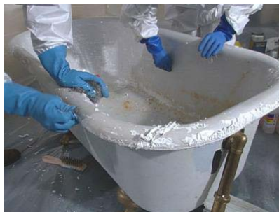
Trabajadores usando un removedor con base de Cloruro de Metileno para quitar la pintura de una bañera antes del acabado final.
