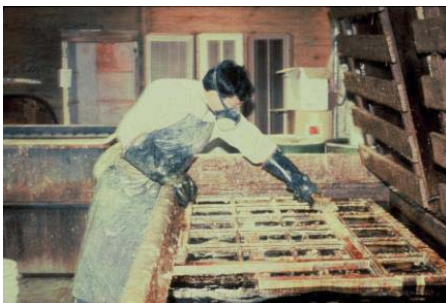
Trabajador removiendo pintura del marco de una ventana en un tanque de inmersión que contiene un removedor con base de Cloruro de Metileno.
